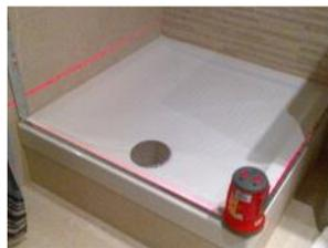
Contrôle de l'équerrage parfait après encollage des barres de seuil et des profils muraux.
