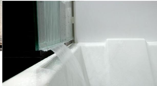
Dans la hauteur, l'étanchéité résulte de jeux réduits entre glaces : par construction, avec méthode, simplement.
