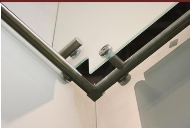
Le raidisseur tubulaire haut de la colonne supporte les faces arrière de la coiffe cubique.
